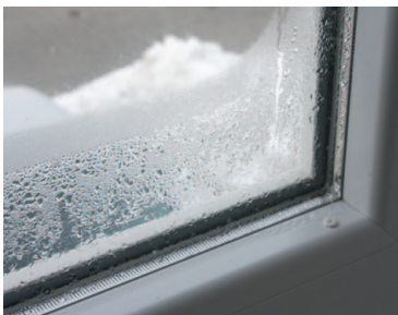
Příklad srážení vlhkosti na studeném povrchu okenní tabulky.
