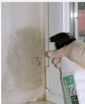
plísně odstraňte za mokra, po vyschnutí aplikujte SANATHERM ostřaňovač plísní
